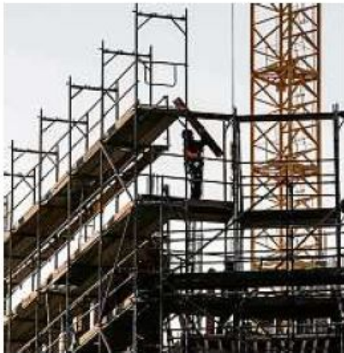
Ein Bauarbeiter hebt auf einer Baustelle ein Brett in die Höhe. Archivfoto: Paul Zinken/dpa
